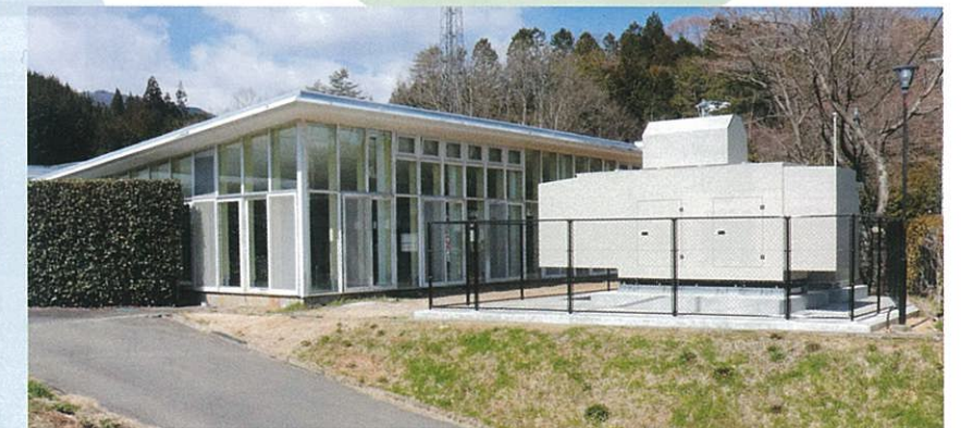
▲ 令和元年度防災・減災事業債を活用して、非常用発電機をいきいきらんど下條に設置しました。同施設は要配慮者避難所に指定しているので、計画的に環境整備を推進します。
