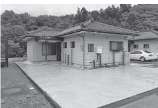
コンクリート舗装した駐車場
