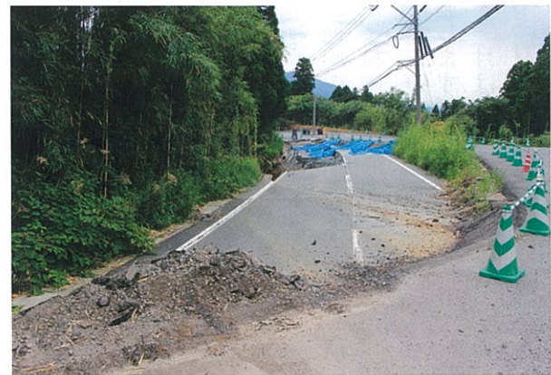
被災地では多くの道路が隆起したり、崩落して通行止めとなっています。
