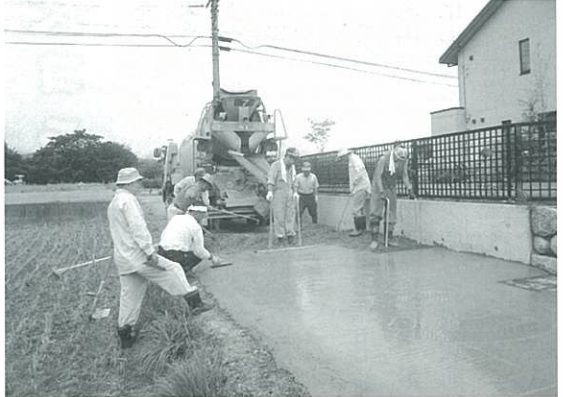
資材支給施工状況
