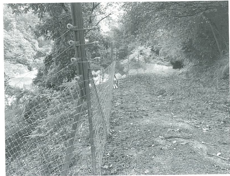
下條村内施設周辺に防護フェンスを設置
