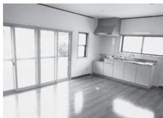
クロスと床を張替え 全室に断熱内窓設置
