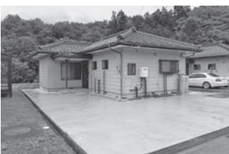
コンクリート舗装した駐車場
