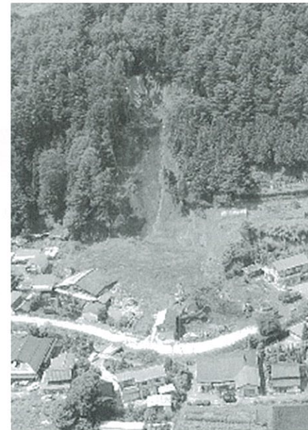
平成18年7月豪雨による県内での土砂崩落
